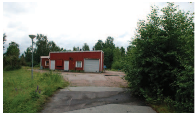
Det nedlagda vattenverket i område E2
