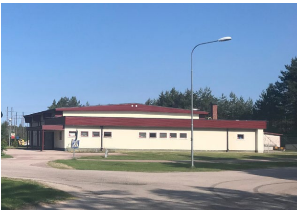
Det före detta badhuset sett från Skolvägen
