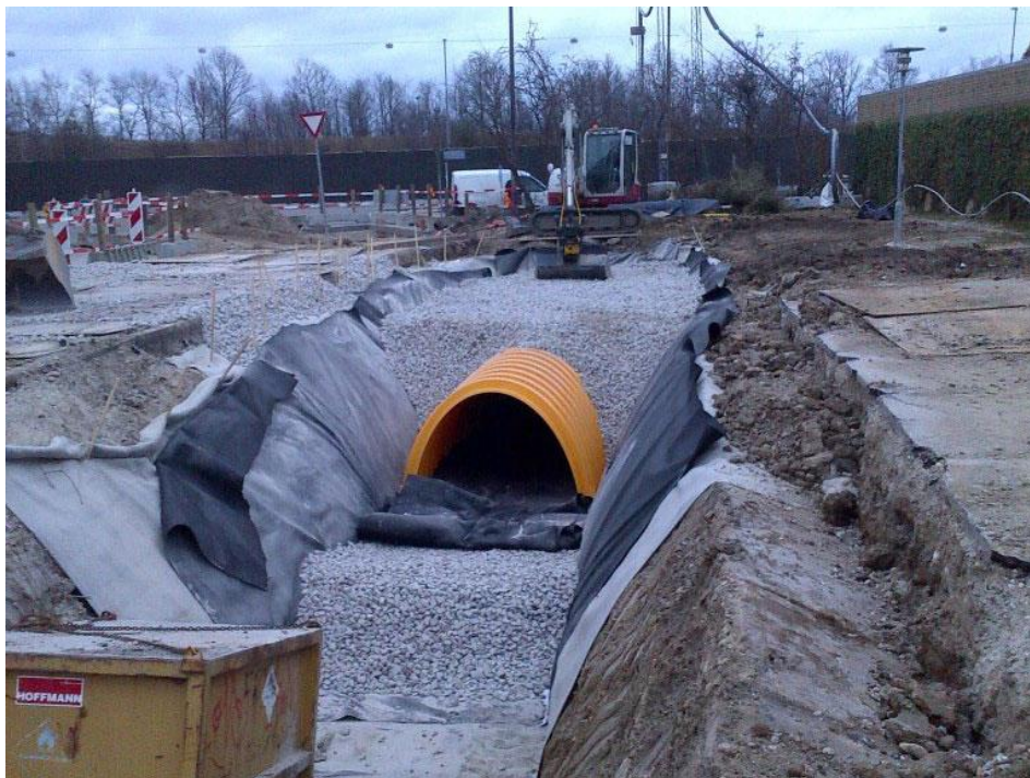
Figur 21. Anläggning av ett tunnelmagasin. Bilden tillhör Milford (Milford, 2020).
