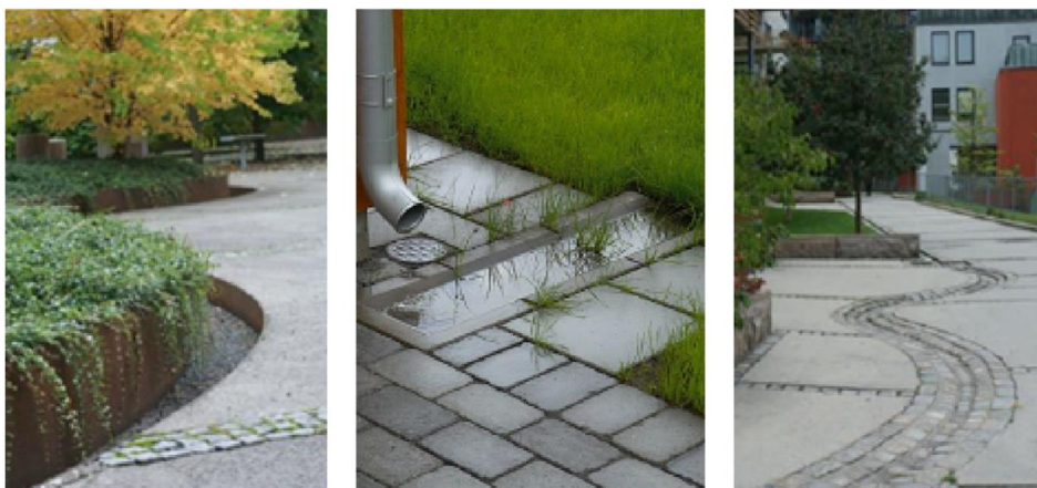
Figur 22. Exempel på utformning av dagvattenrännor i urban miljö. (Det högra och vänstra exemplet är foton från Sweco, exemplet i mitten kommer från S:t Eriks rännalsplattor)
