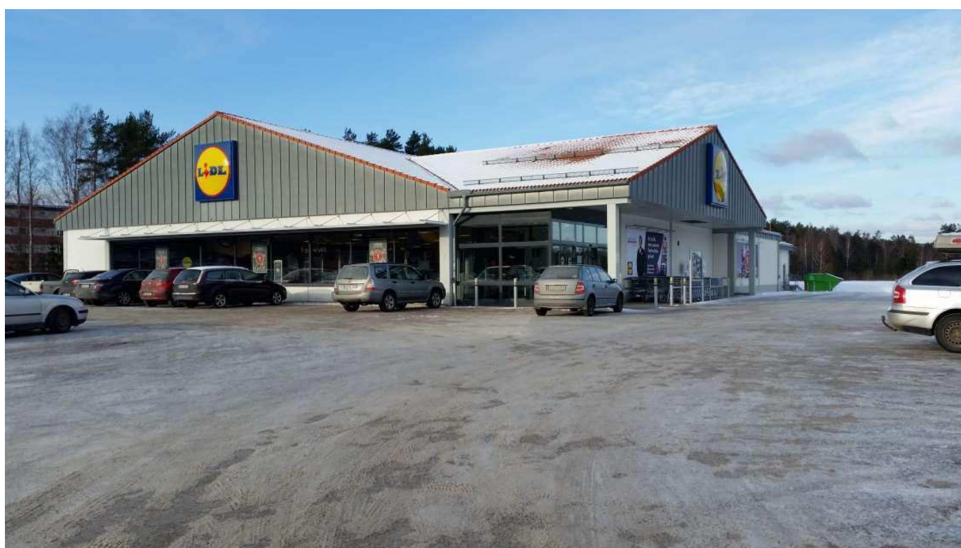
Befintlig butik sedd från söder vid Parkvägen
