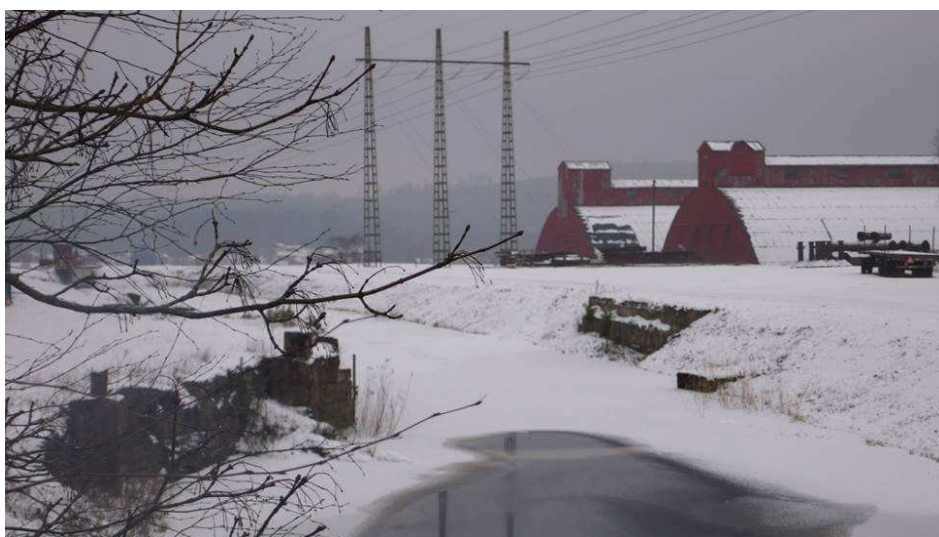
Det ursprungliga järnverksområdet med kolhusen.
