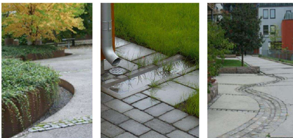
Figur 20. Exempel på utformning av dagvattenrännor i urban miljö. (Det högra och vänstra exemplet är foton från Sweco, exemplet i mitten kommer från S:t Eriks rännalsplattor)
