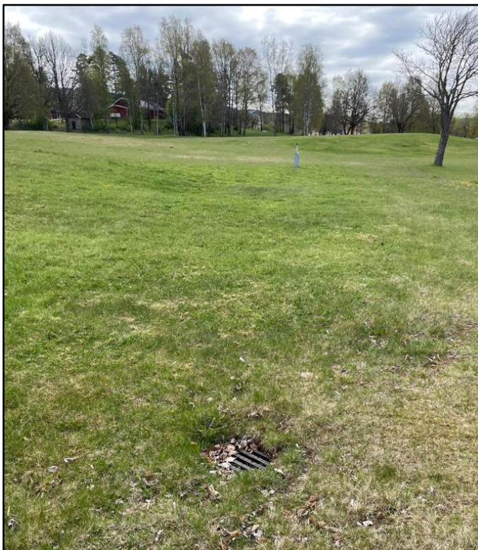
Figur 9. Befintlig dagvattenbrunn inom utredningsområdet.
