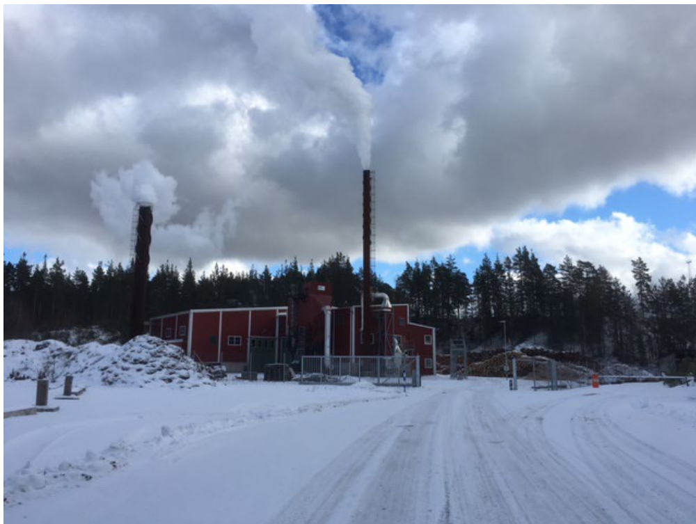
Figur 5. Befintlig fjärrvärmelanläggning med tillhörande skorstenar.
