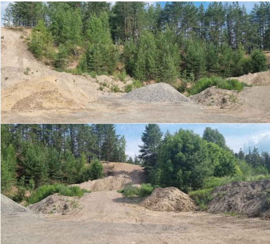
Figur 7 Foto befintliga slänter norr om värmeverk. Punkt A och B.
