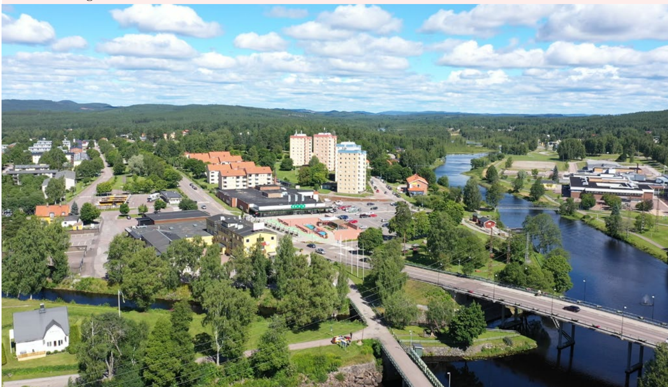
Vy över centrala Hagfors med de karaktäristiska höghusen (Foto: Pär Thörne, Greengate)
