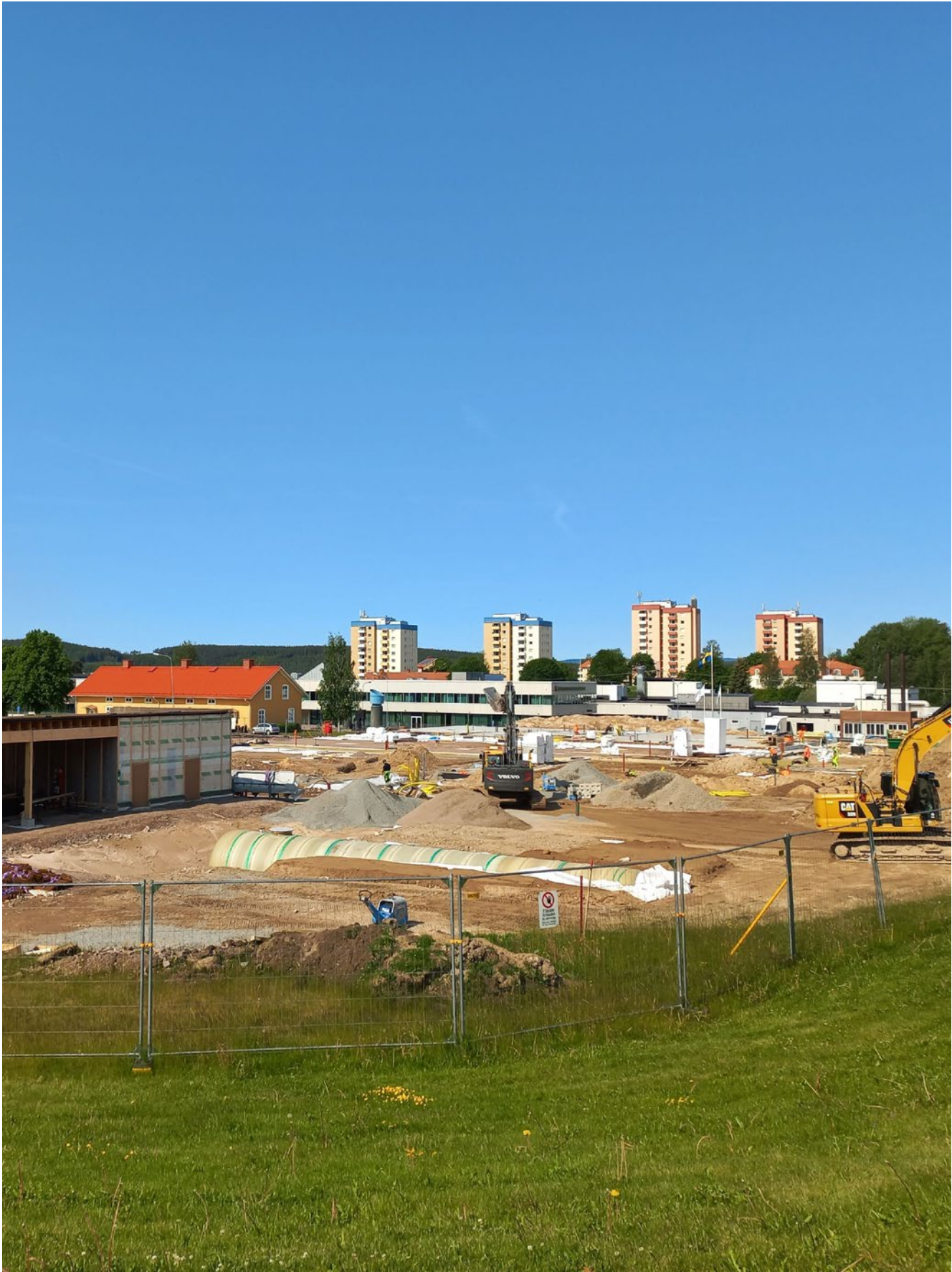
Vy över teknikhusbygget på Gärdet i Hagfors, med de klassiska "höghusa" i bakgrunden.
