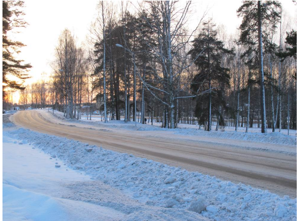
Kyrkogårdsvägen mot söder med infarten till området till höger
